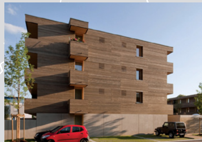
5 e% energieeffizienter Wohnungsbau Ansbach
